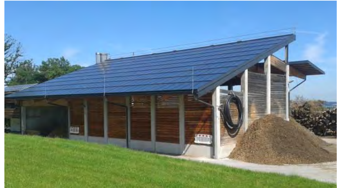
Photo: Nahwärme Eugendorf, Austria
